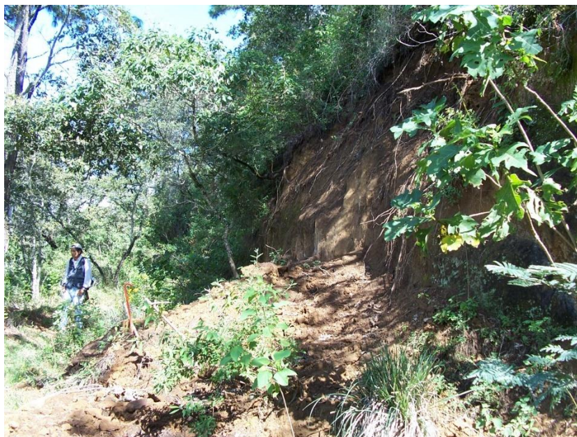
Figura. 1. Ejemplo de desprendimiento en un corte vertical de una vereda en la parte alta del Parque las Peñas
